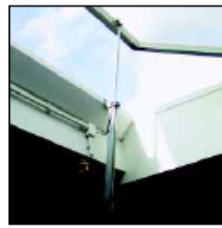
Stellmotor mit Entrauchungsklappe
